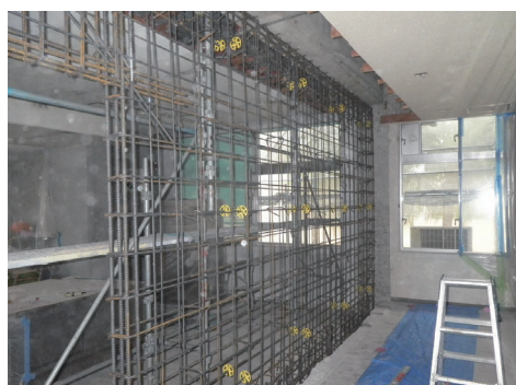
RC 造耐震補強
