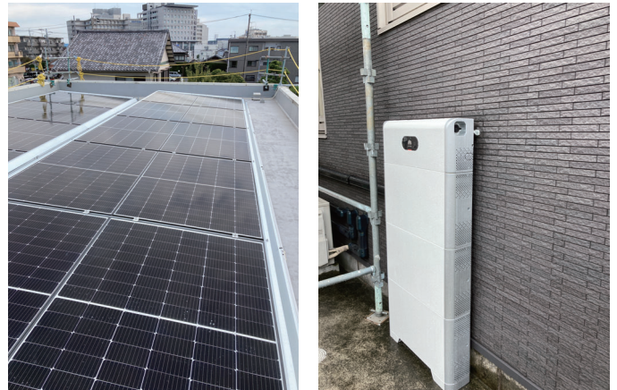
太陽光 (8.3kw)+ 蓄電池 (15kw) 設置工事
