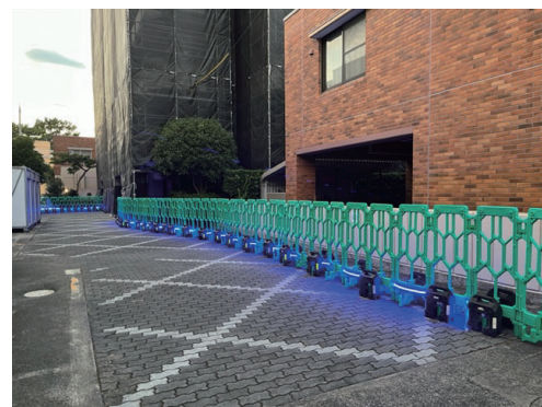
第三者動線に対しての 工事中 LED 安全灯の設置
