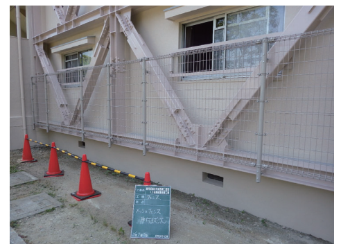
耐震補強後付けブレース
