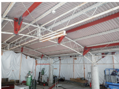
鉄骨造耐震補強
