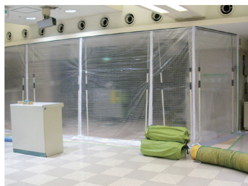
粉塵対策仮設間仕切り
