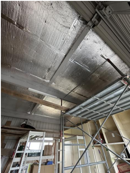
遮熱シート屋根内側に施工中
