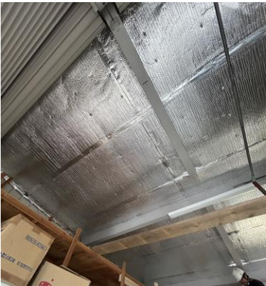
遮熱シート施工後
