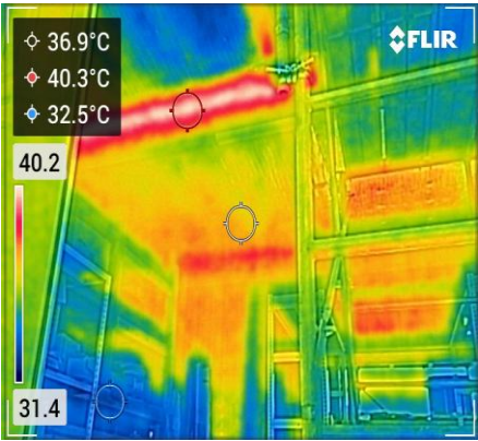
施工前サーモグラフィー
