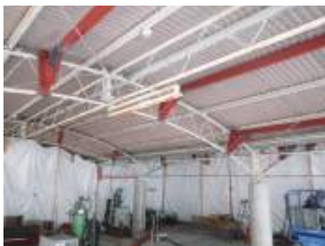
鉄骨造耐震補強
