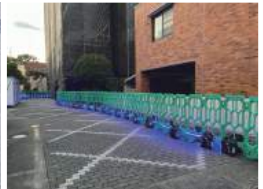
第三者動線に対しての 工事中 LED 安全灯の設置
