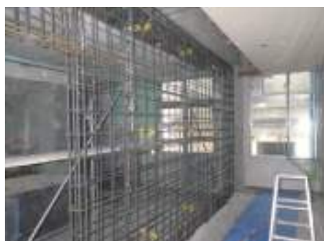
RC 造耐震補強
