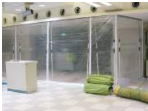
粉塵対策仮設間仕切り
