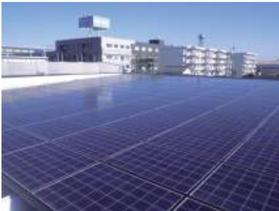
太陽光 (38.41kw)+ 蓄電池 (8.8kw) 設置工事 自社社屋に設置 → 災害拠点として一般開放
