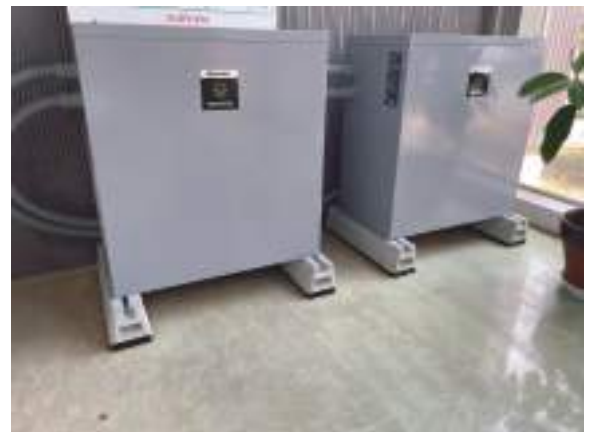
太陽光 (38.41kw)+ 蓄電池 (8.8kw) 設置工事 自社社屋に設置 → 災害拠点として一般開放
