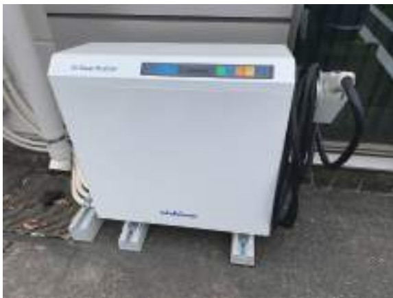
太陽光 (38.41kw)+ 蓄電池 (8.8kw) 設置工事 自社社屋に設置 → 災害拠点として一般開放
