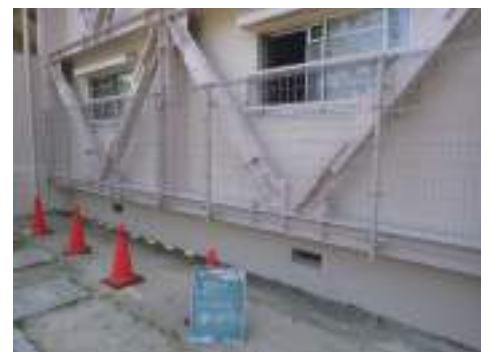
耐震補強後付けブレース
