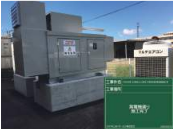
非常用自家発電設備工事
