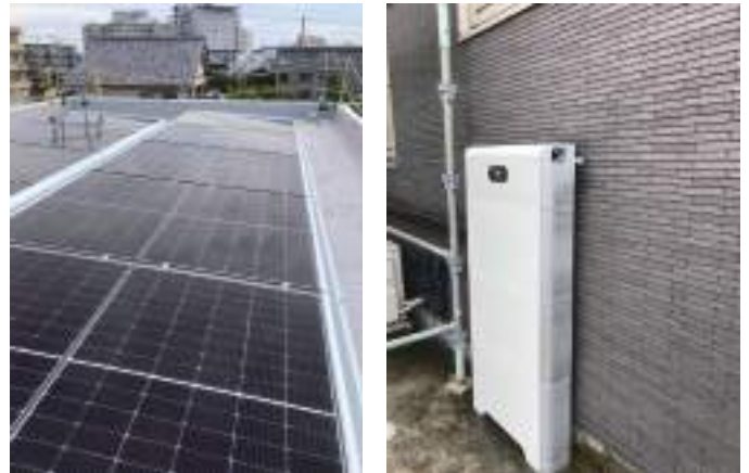
太陽光 (8.3kw)+ 蓄電池 (15kw) 設置工事
